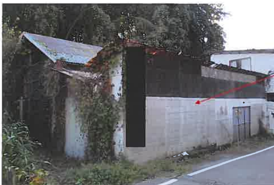
物件6 (附属建物)
