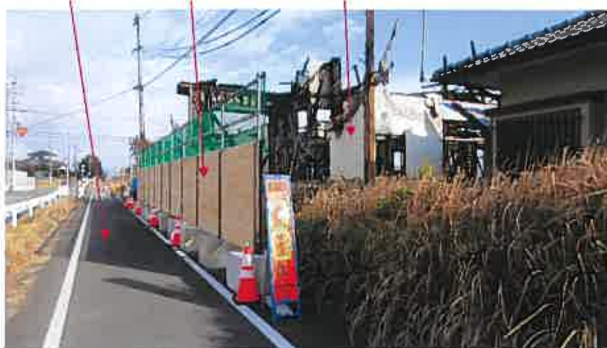
自転車道路 倒壊防止用フェンス 物件 2
