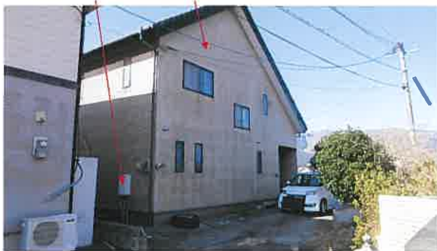
ガス給湯器 物件 3 (敷地が物件 2)
