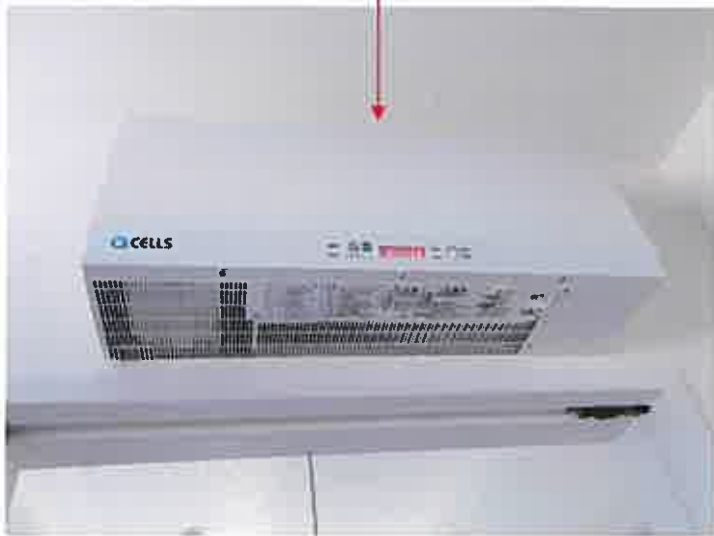
(写真 14 ) 太陽光発電システムのパワーコンディショナー
