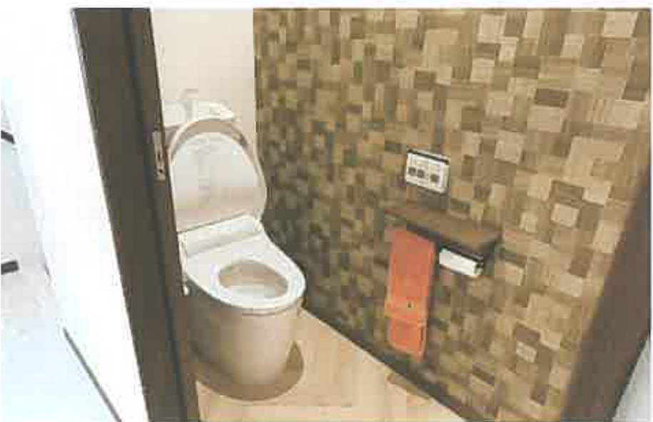
物件3 (2階トイレ)
