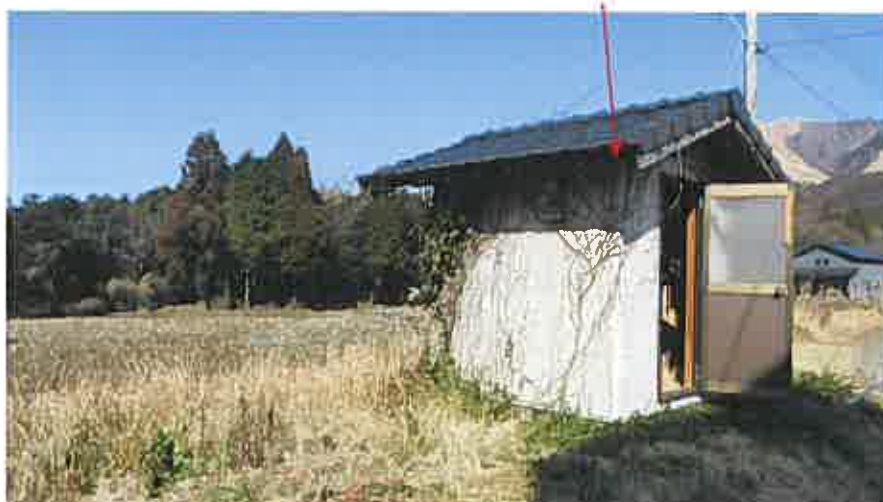
目的外建物 (ポンプ室)
