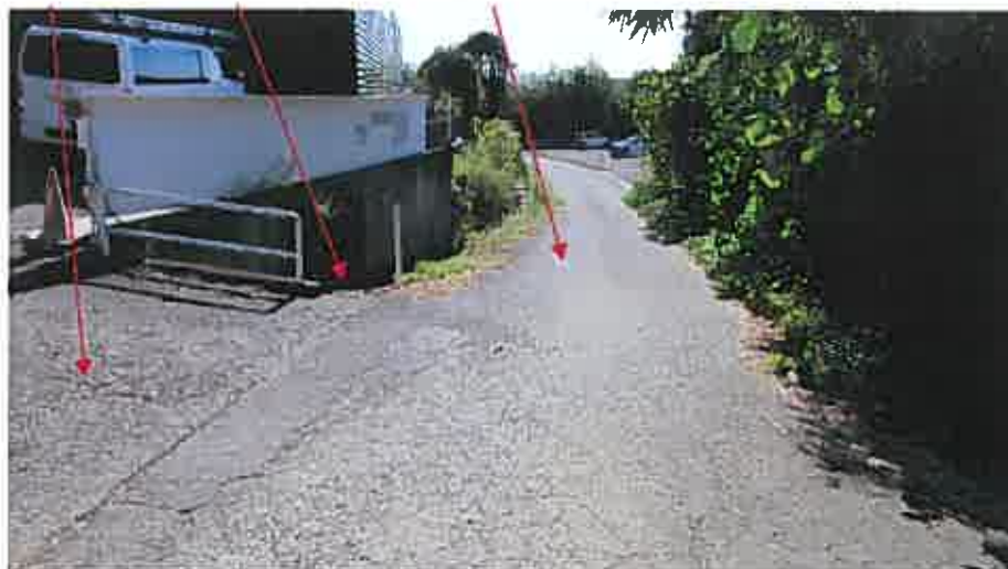
(写真 13 ) 橋 水路 里道
