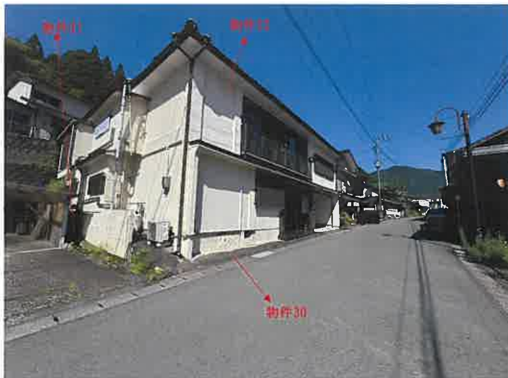
南西方より対象不動産を望む
