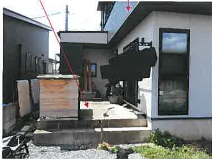
(写真 4 ) コンクリートデッキ 物件2 (敷地が物件1)
