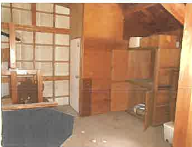
物件 2 附属建物符号 5・2 階内部
