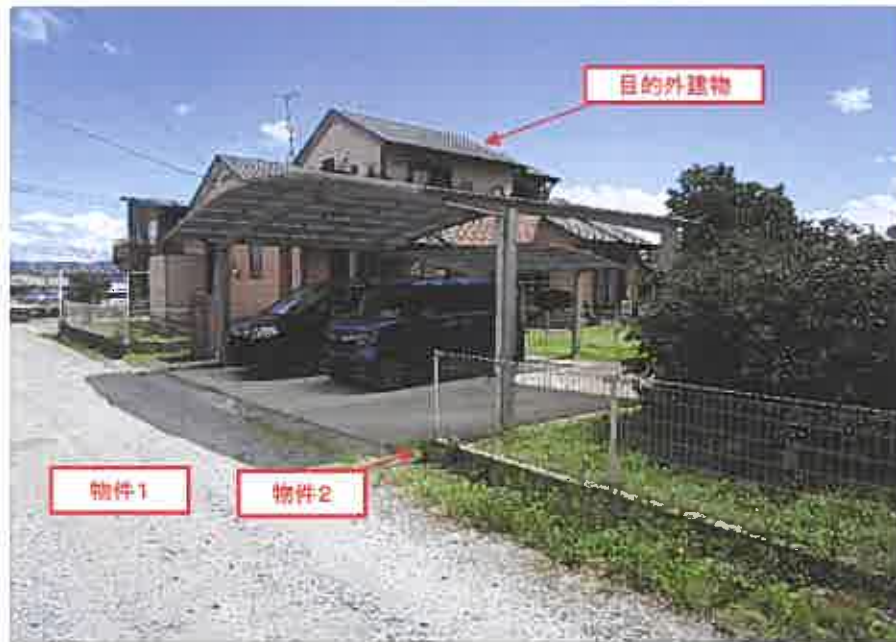
物件南西方より撮影
