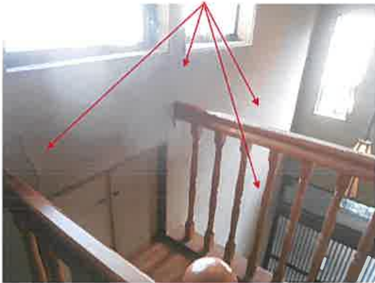
2階吹抜付近 壁の亀裂
