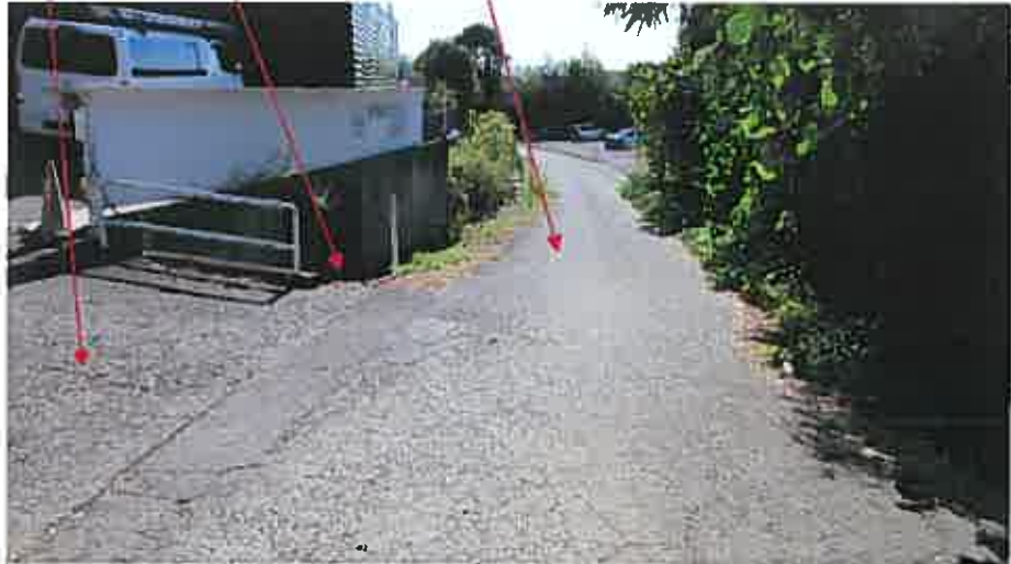
(写真 13 ) 橋 水路 里道
