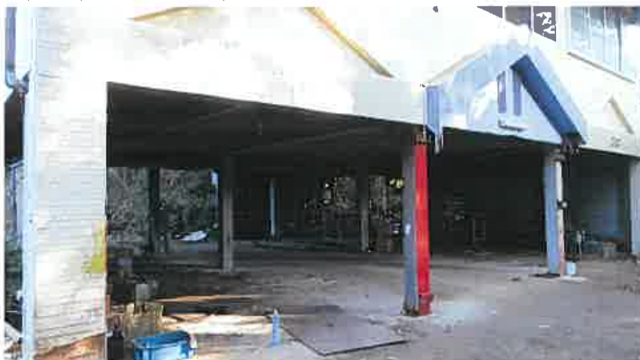
(写真 3 ) 下部は物件 25 のピロティ
