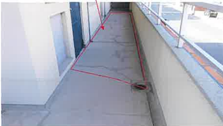
2階外廊下に生じた亀裂
