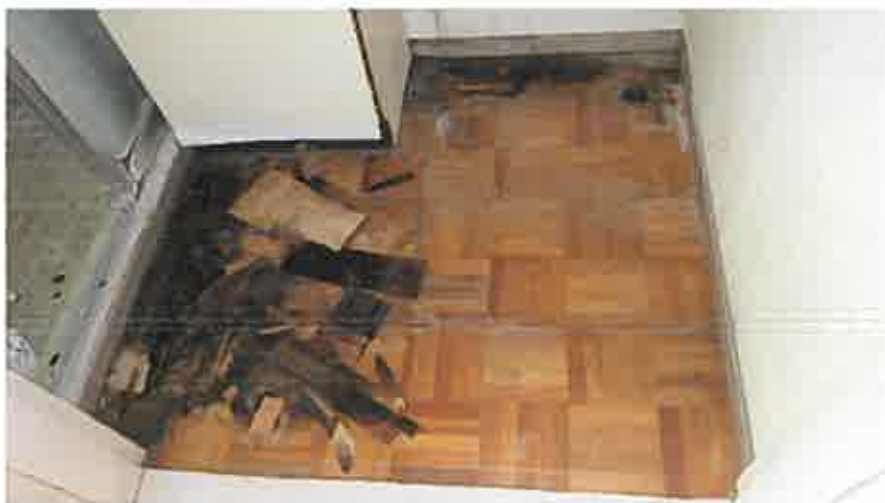
床の損傷状況
