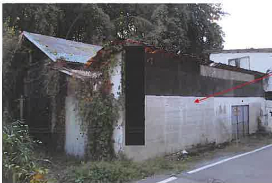
物件6 (附属建物)
