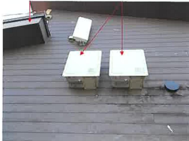
(写真 4 ) 物件 2 (敷地が物件 1) 太陽光発電パワーコンディショナー
