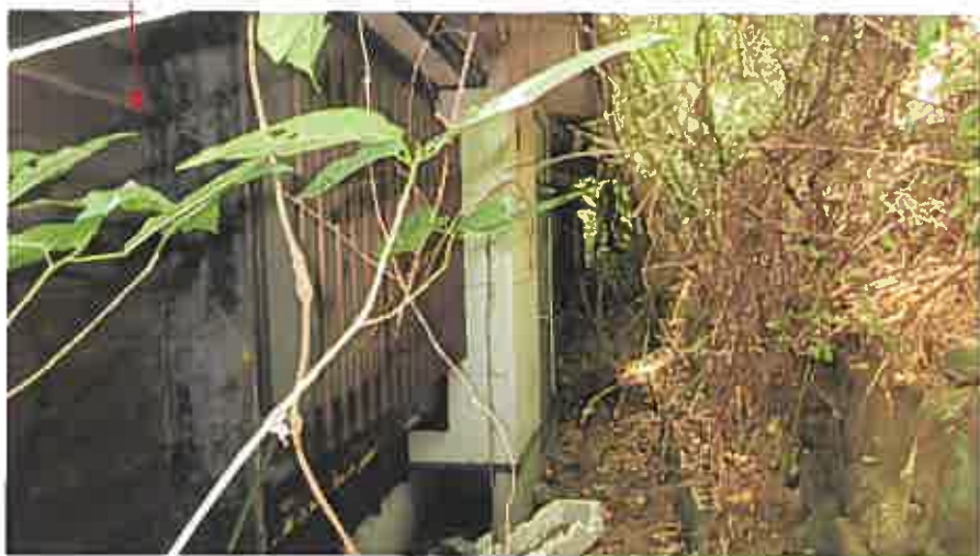
北側隣地 (1950 番 8) との境界付近
