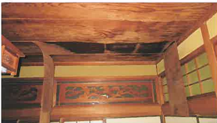
天井の損傷状況
