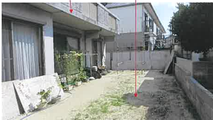
物件 4 の主である建物 物件 1 土地
