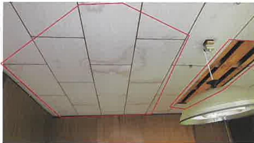
雨漏りの痕跡及び天井板の崩落状況
