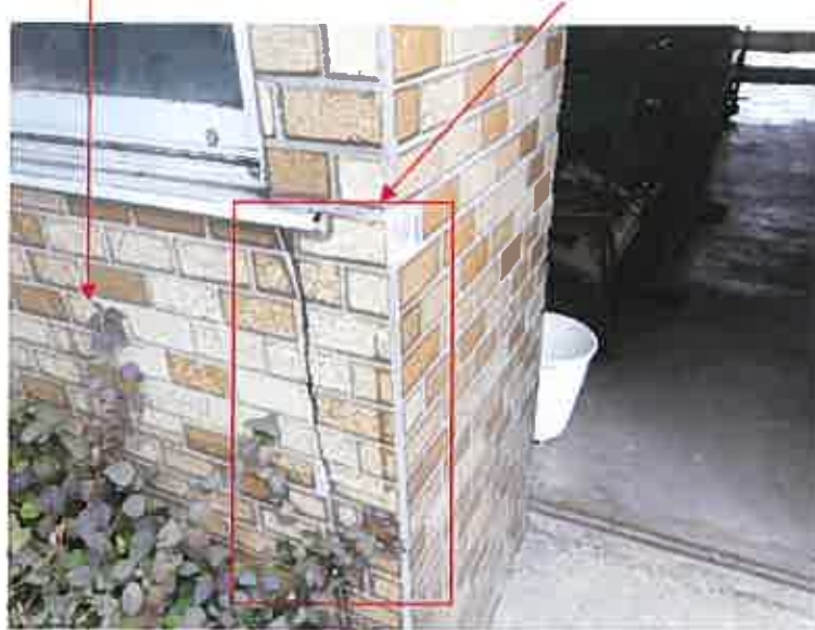
(写真 7 ) 物件 2 (敷地が物件 1) タイルの脱落、ずれ
