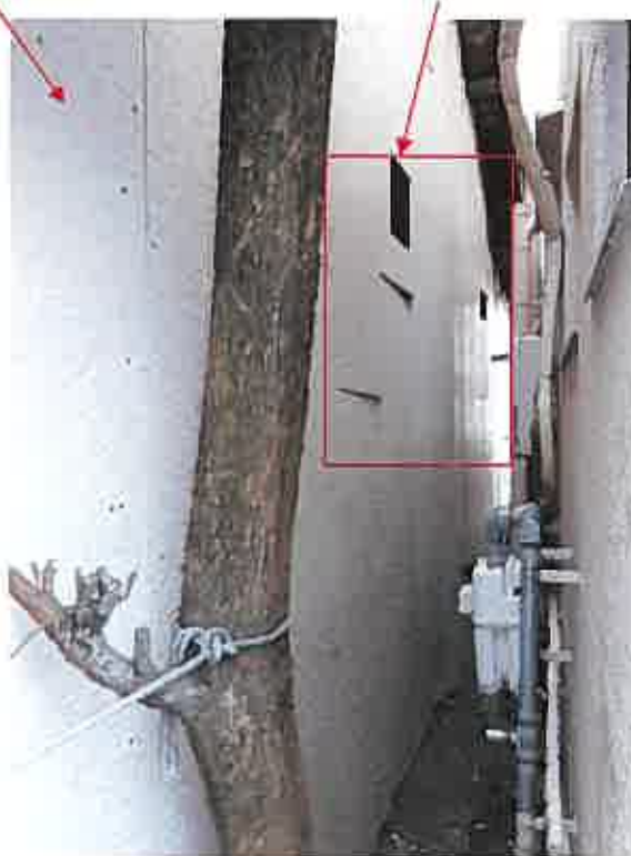
(写真 7 ) 物件 2 (敷地が物件 1) タイルの脱落、ずれ
