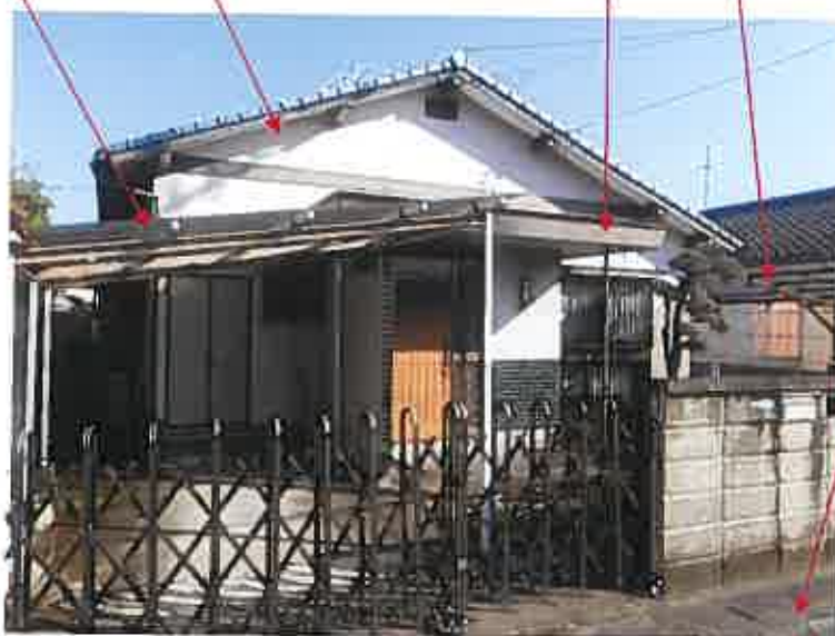
(写真 2 ) カーポート 市道 下屋 物件 2 (敷地が物件 1) カーポート
