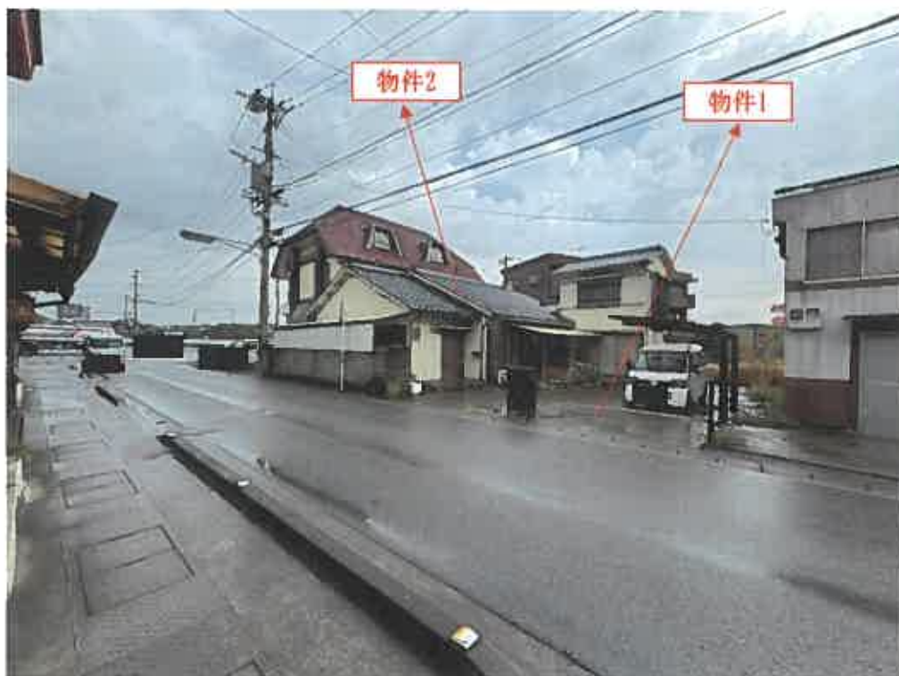
南西方より対象不動産を望む
