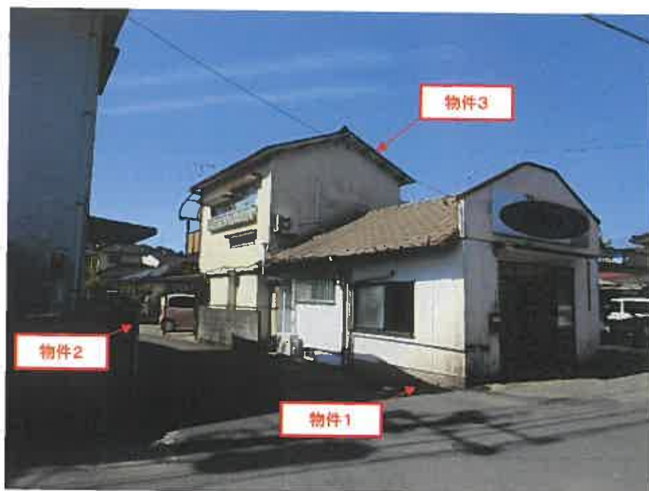
物件東方より撮影(物件番号1、2、3)
