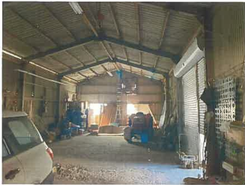
写真⑦：附属建物符号1(倉庫)
