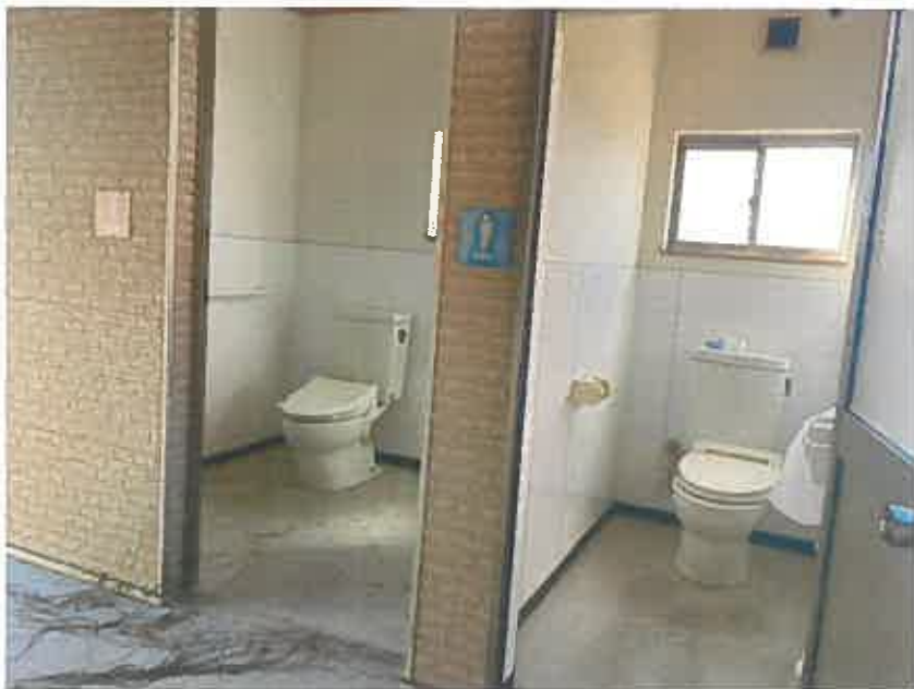
写真⑨：未登記附属建物(便所)
