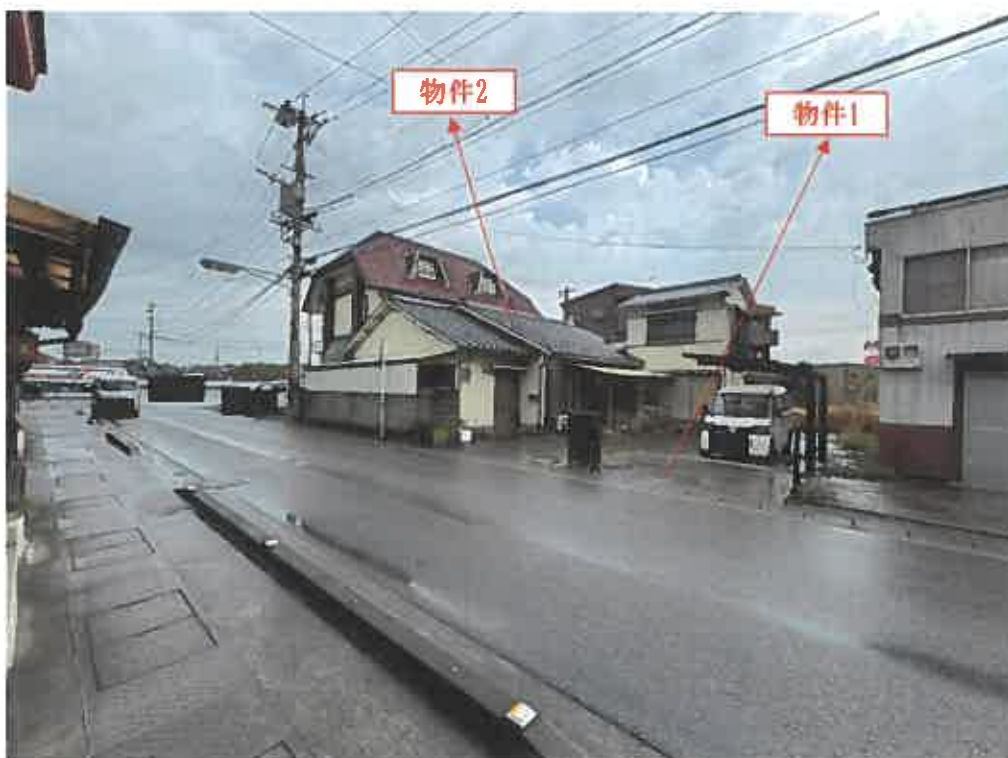
南西方より対象不動産を望む
