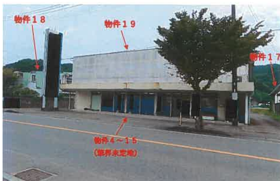
物件19（南西方より撮影）
