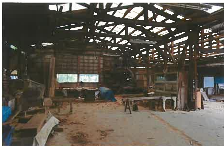
物件16（倉庫内部）
