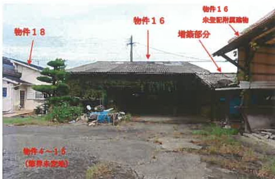
物件16,18（南方より撮影）
