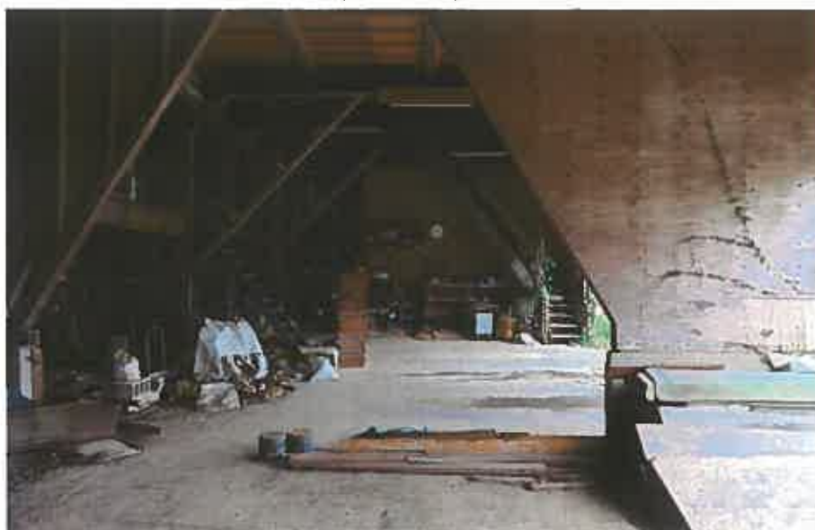
物件17（倉庫内部）
