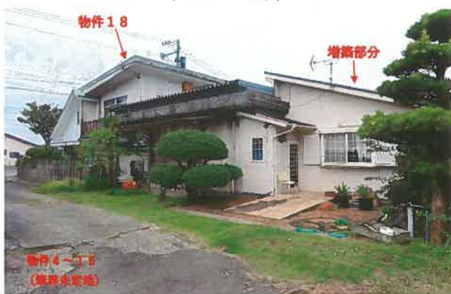
物件18（南東方より撮影）
