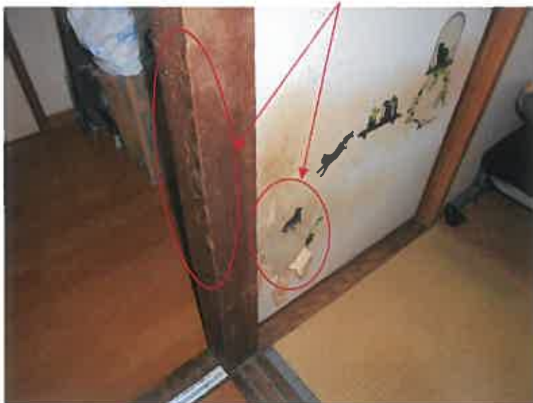
犬による柱とドアの損傷
