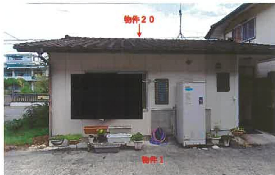
物件1,20（南西方より）
