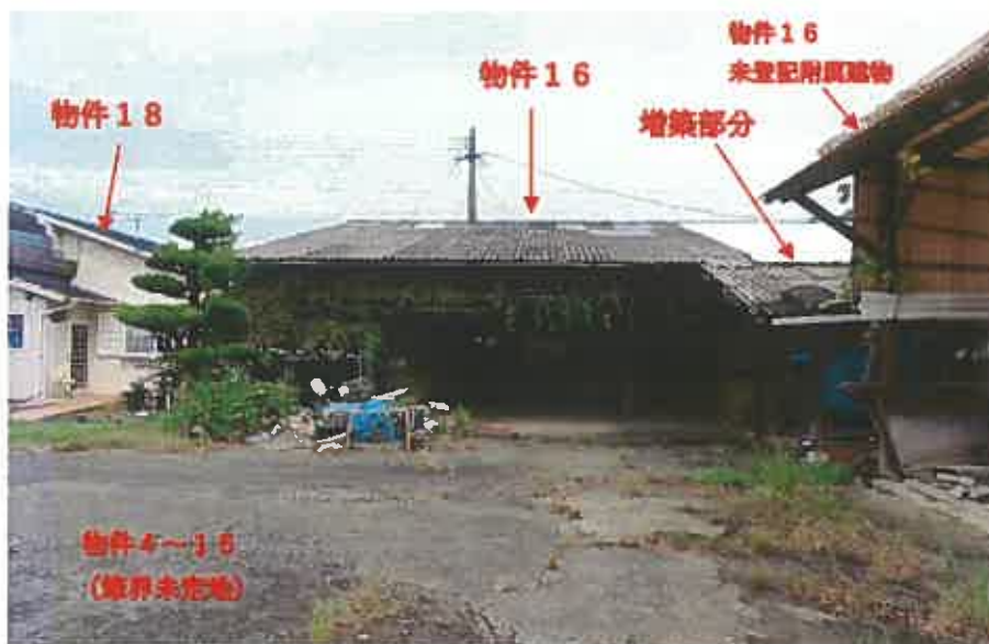
物件16,18（南方より撮影）
