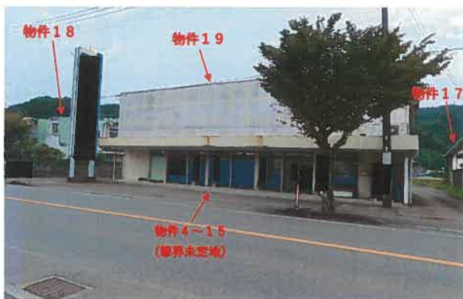
物件19（南西方より撮影）
