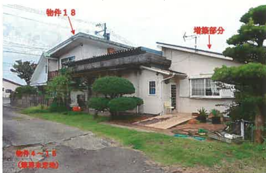
物件18（南東方より撮影）
