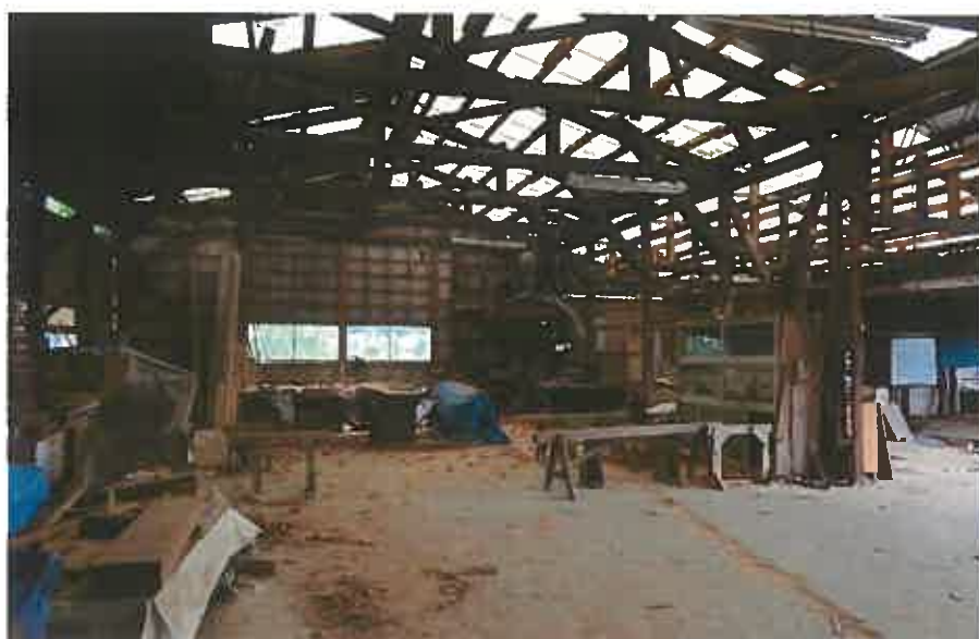
物件16（倉庫内部）
