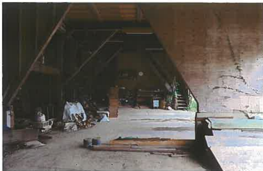
物件17（倉庫内部）
