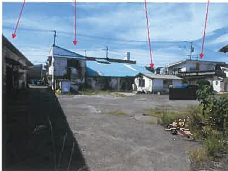
(写真 14 ) 物件 1 6 倉 庫
