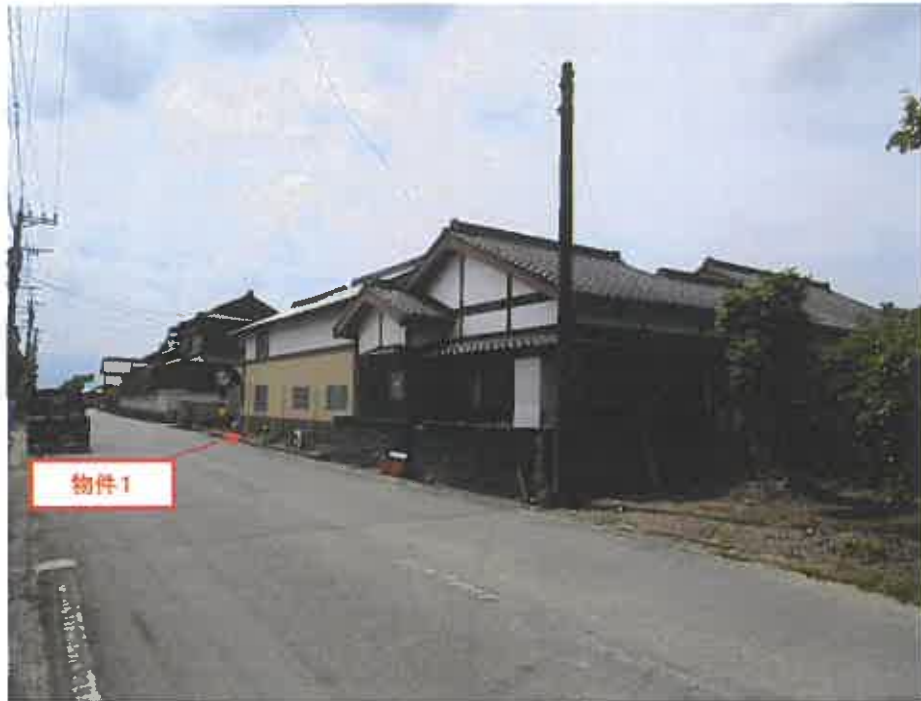
物件北方より撮影
