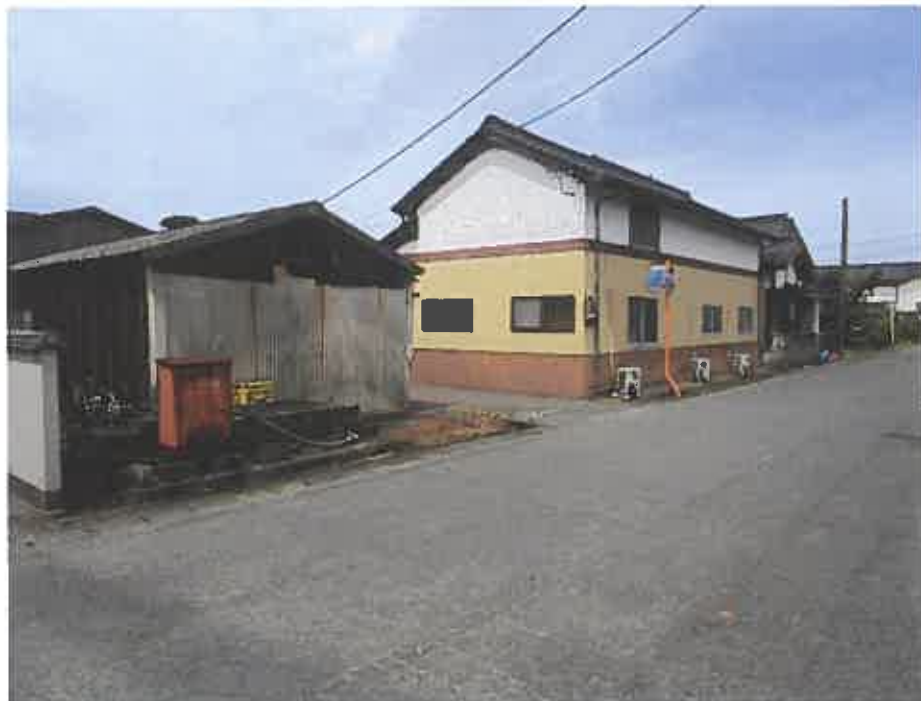
物件東方より撮影
