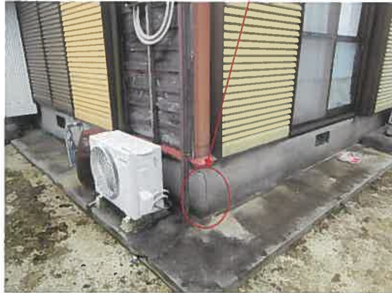
南西角 外壁の破損
