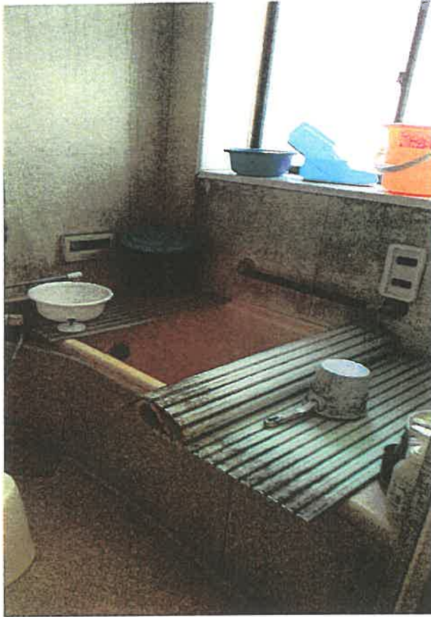
物件 2 内部状況
