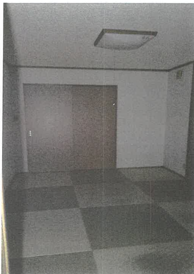
物件 2 1 階内部状況
