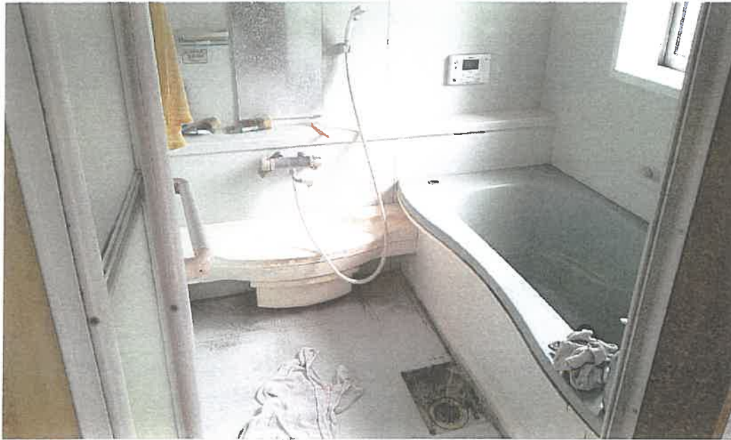
物件 2 1 階内部状況
