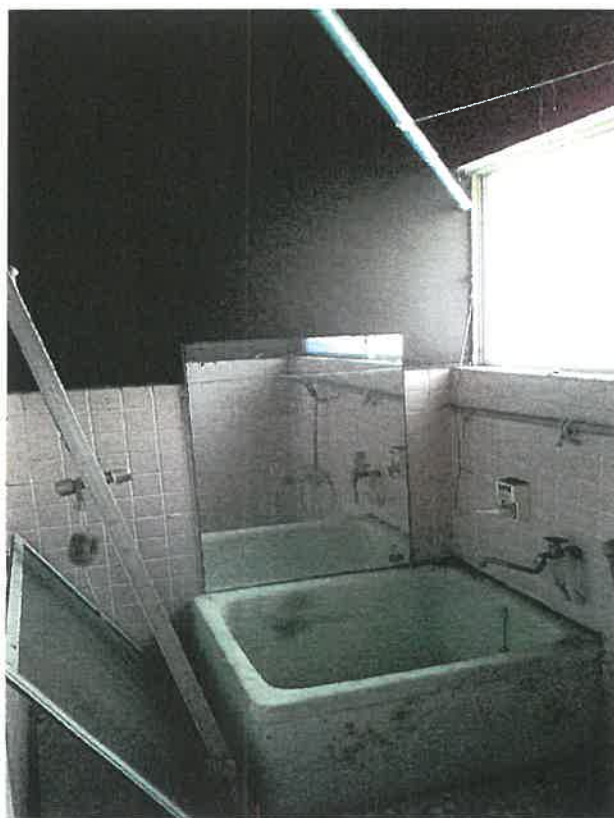
物件 3 内部状況
