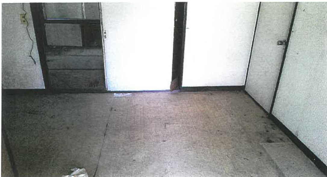
物件 3 内部状況
