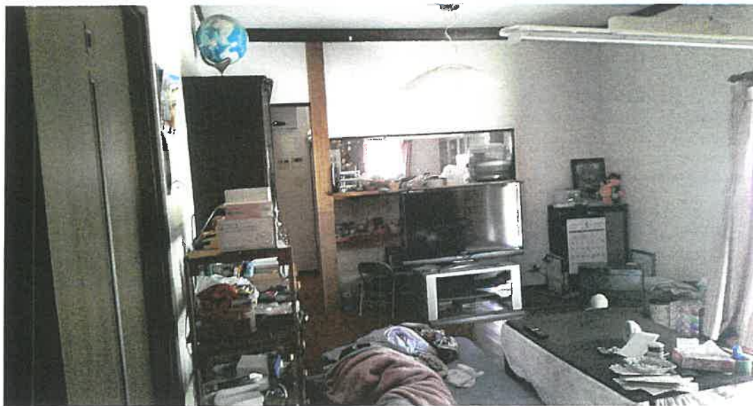
物件3 1階内部状況
