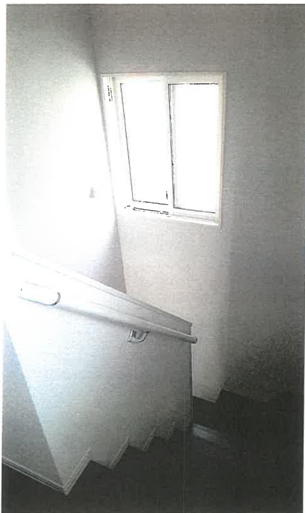
物件 4 2 階内部状況
