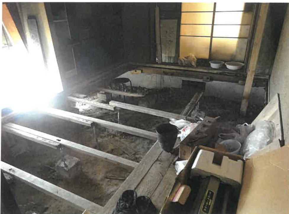
写真14 本件建物内部(2階居宅部分)
