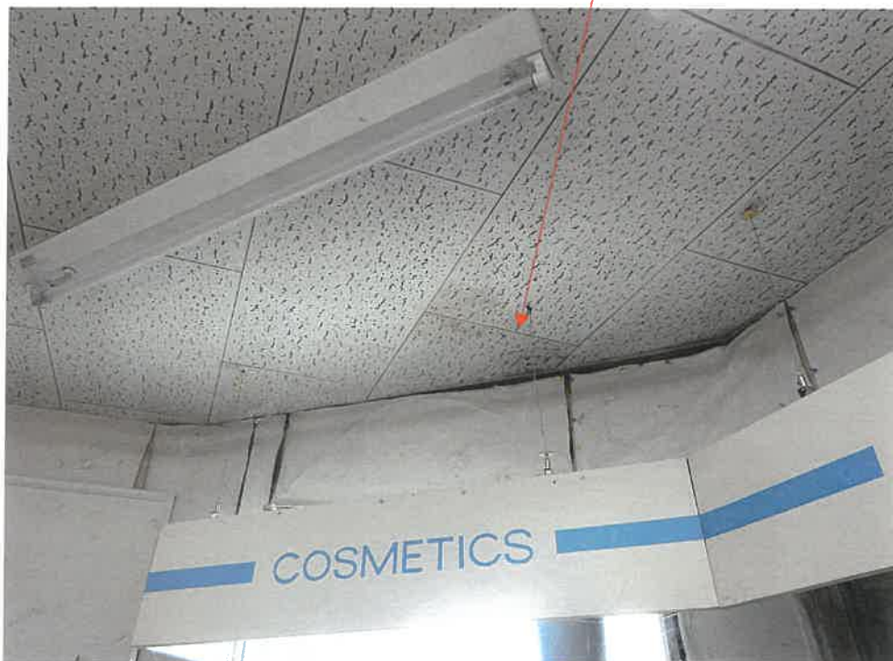
写真8 本件建物内部(1階居宅部分)
