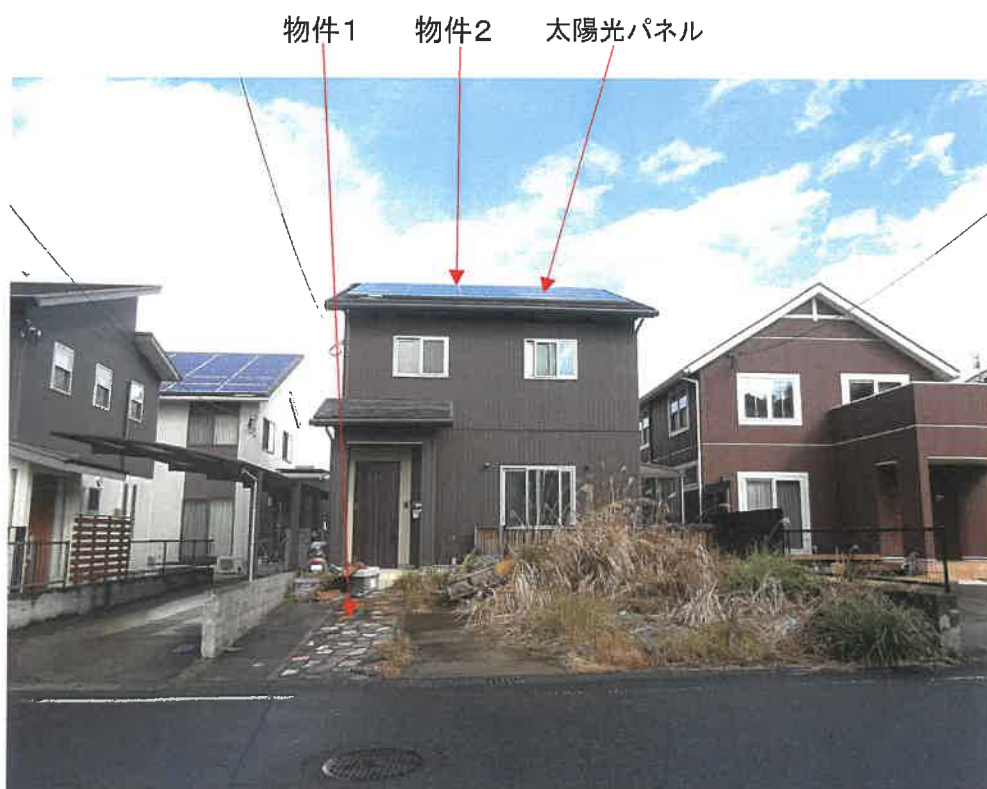
写真1 本件建物外観
