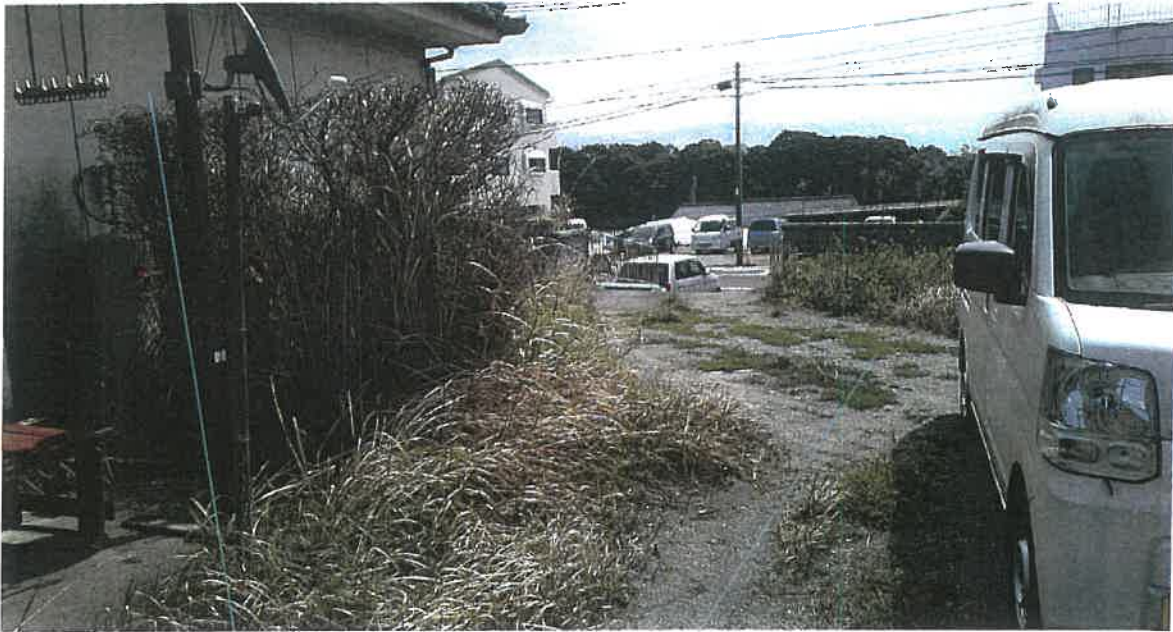
物件 4 主たる建物
