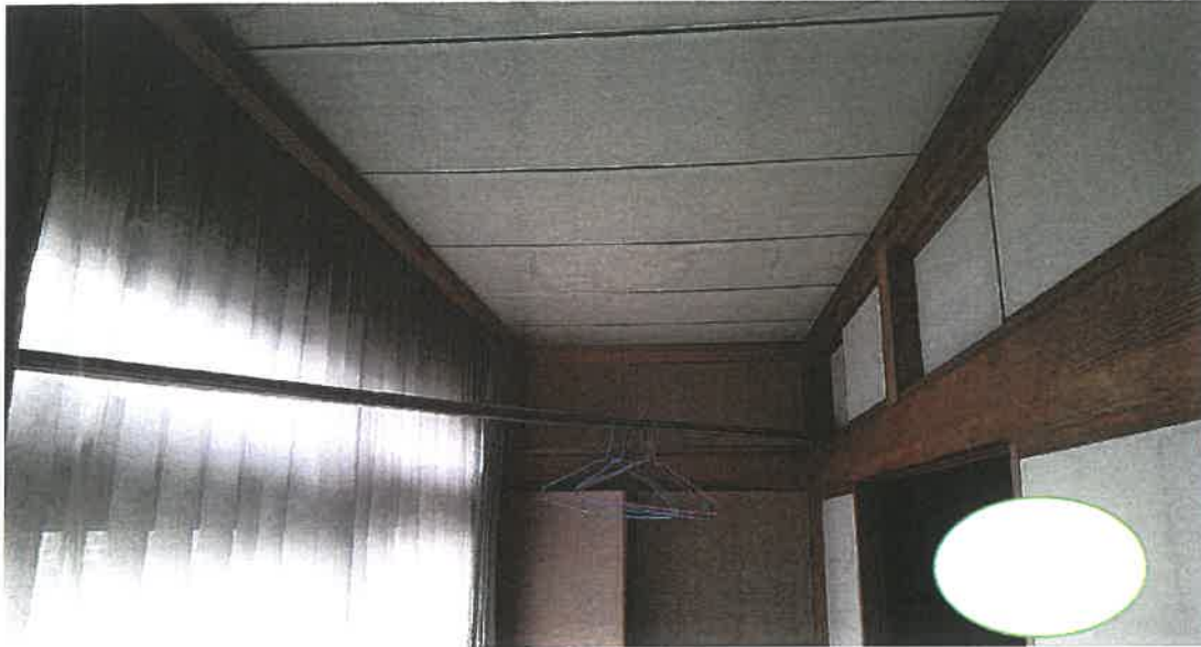
物件4 内部状況
