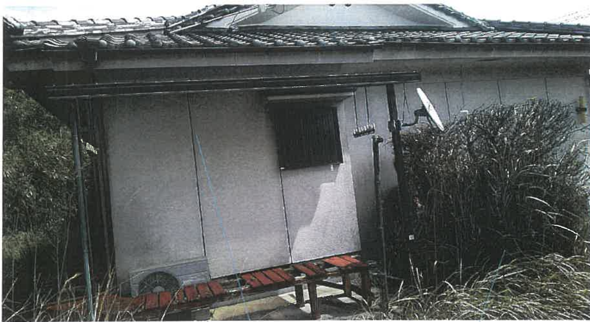
物件 4 主たる建物
