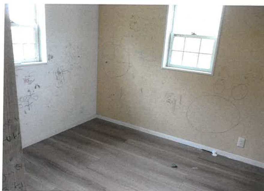
⑫2階東側洋室
