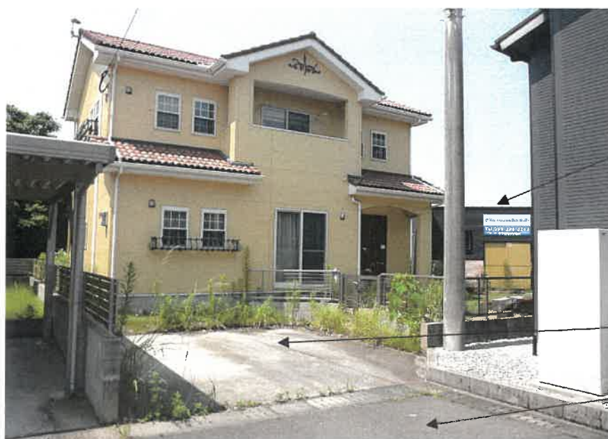
③本建物（南西）
