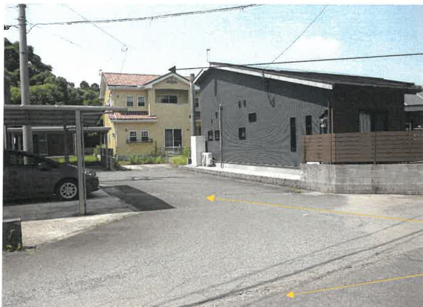
①対象物件全景（南）
