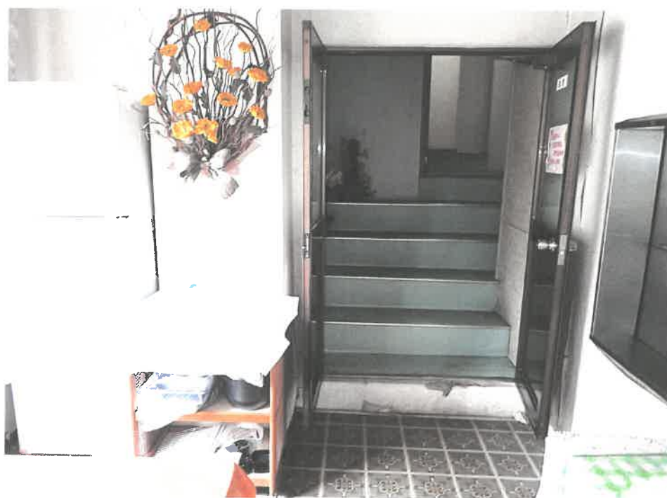
物件4 増築部分（通路階段）
