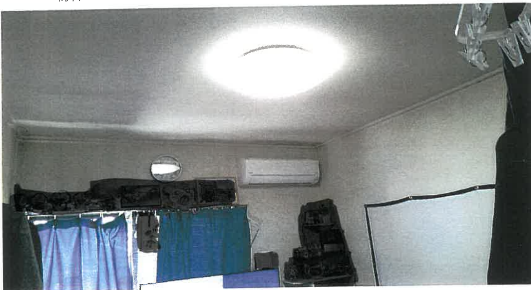
物件 4 202号室内部状況
