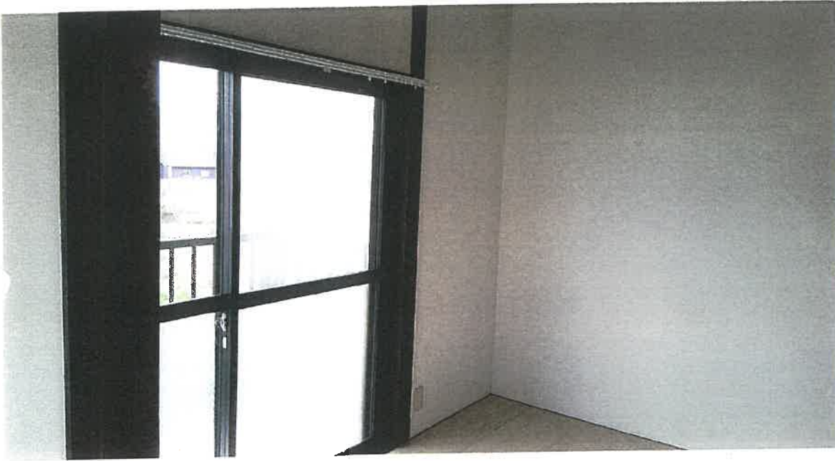
物件 4 201号室内部状況
