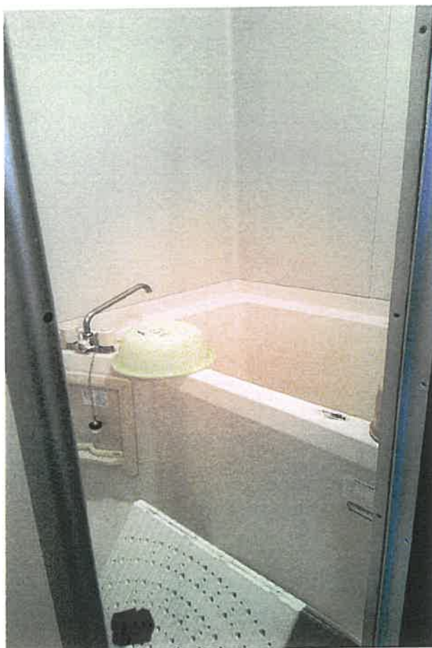
物件4 205号室内部状況
