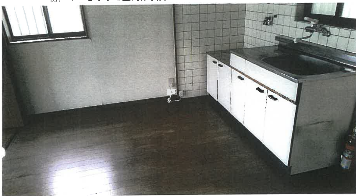
物件4 103号室内部状況
