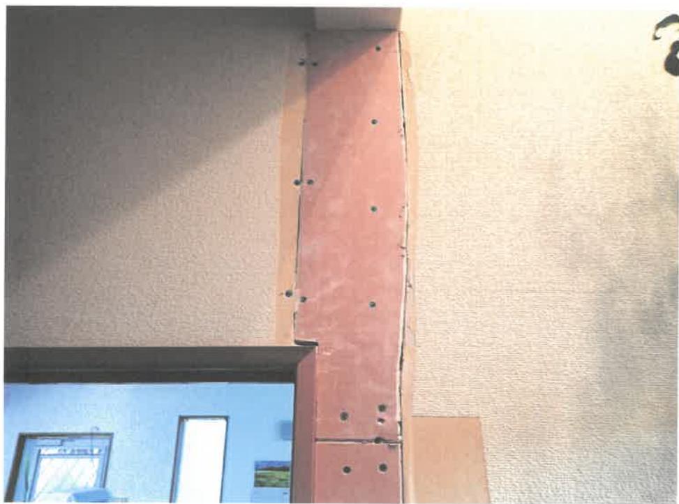
物件 8 建物内壁の補修状況
