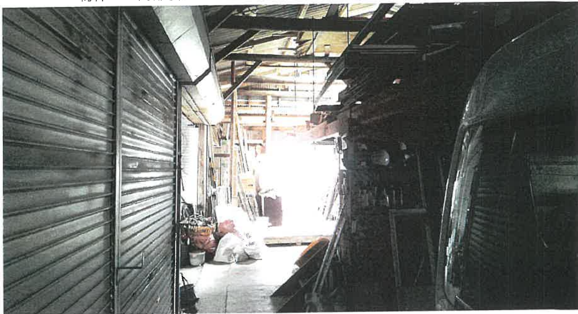
物件 7 内部状況
