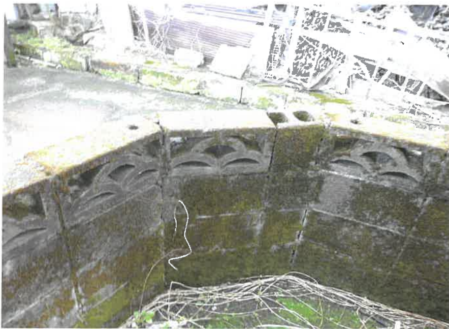
④南東端隅切り部分
