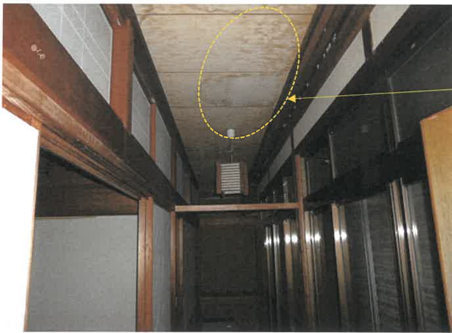
⑩南方縁側天井
