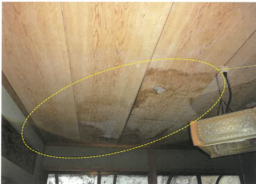
⑨南西方和室天井
