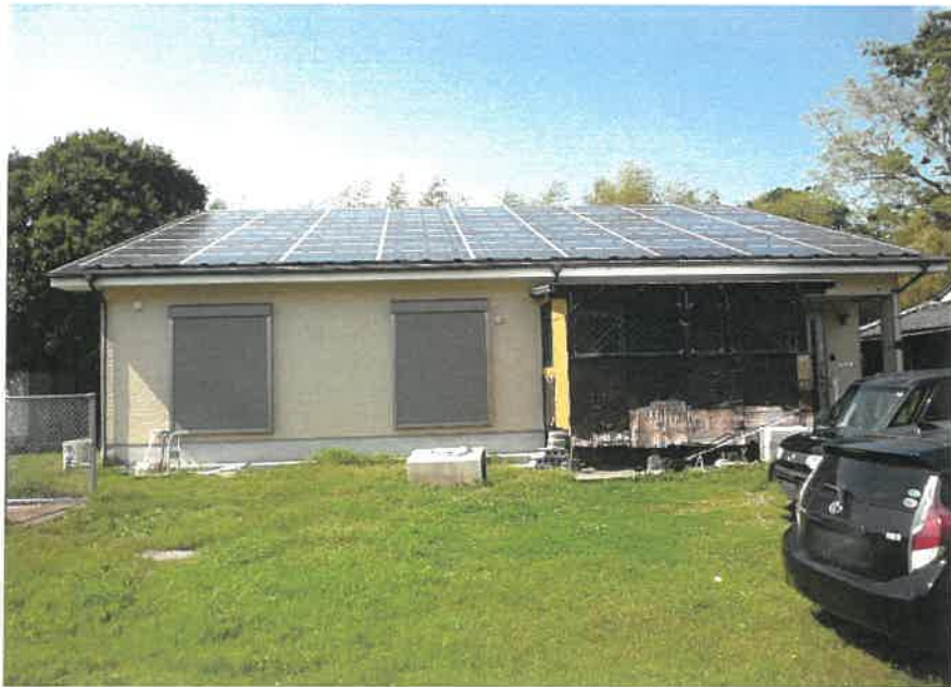
④本建物（南）
