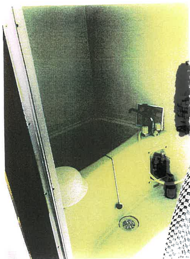
物件11 103号室 内部状況 写真19
