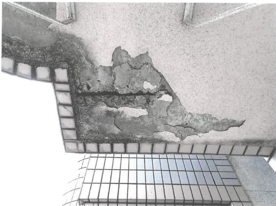
ベランダの上（天井）部分の状況
