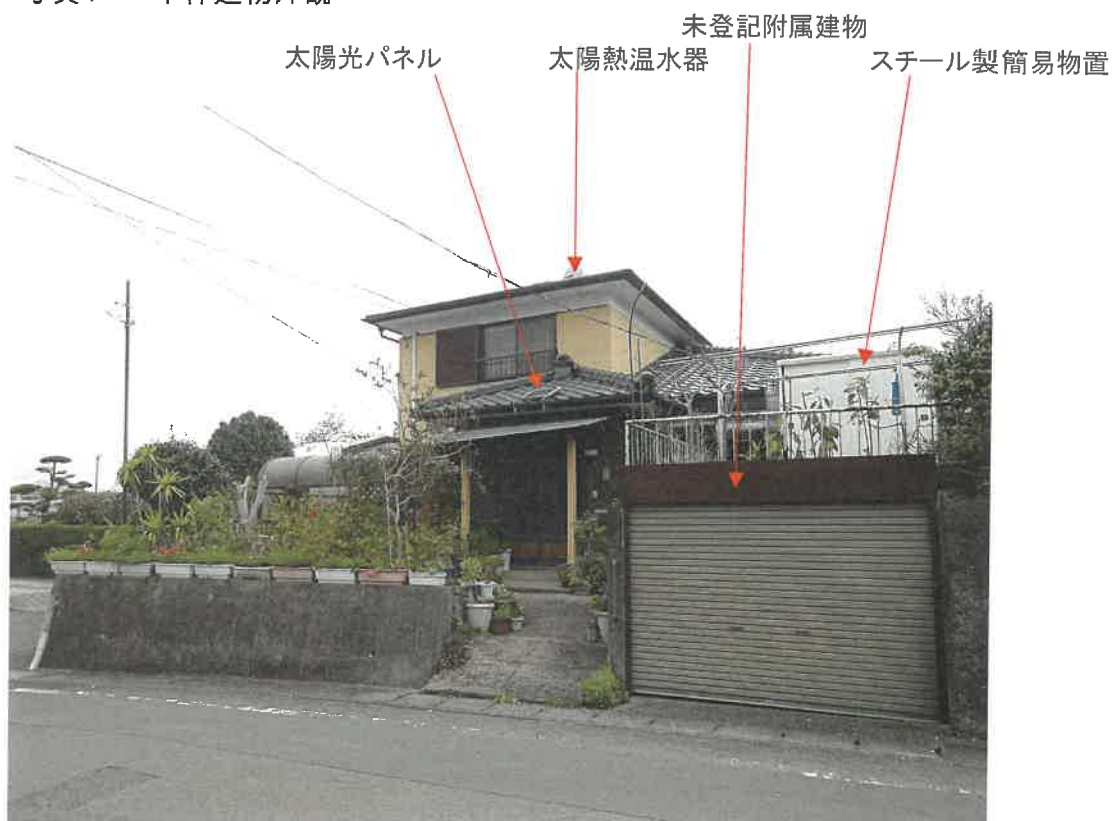
写真1 本件建物外観
