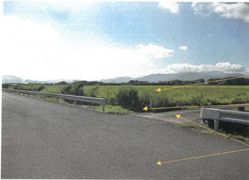
④対象物件（北西）
