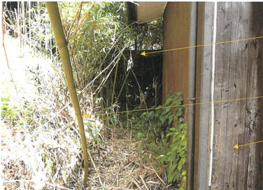
⑤本建物 (外観)
