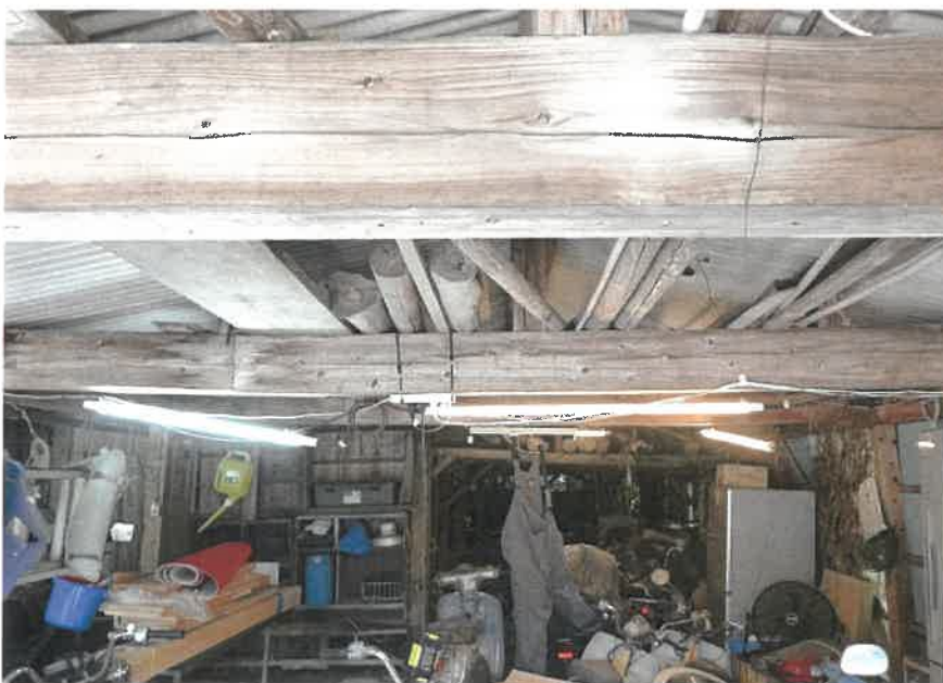
⑫附属建物のさしかけ （内部）
