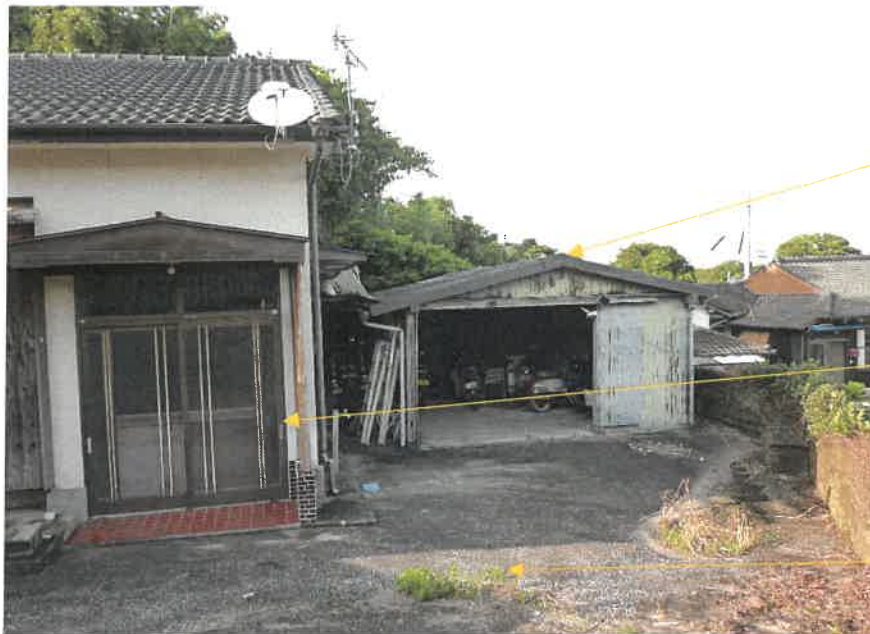
④附属建物のさしかけ (外観)
